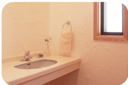
トイレ・風呂・循環風呂・洗濯機
